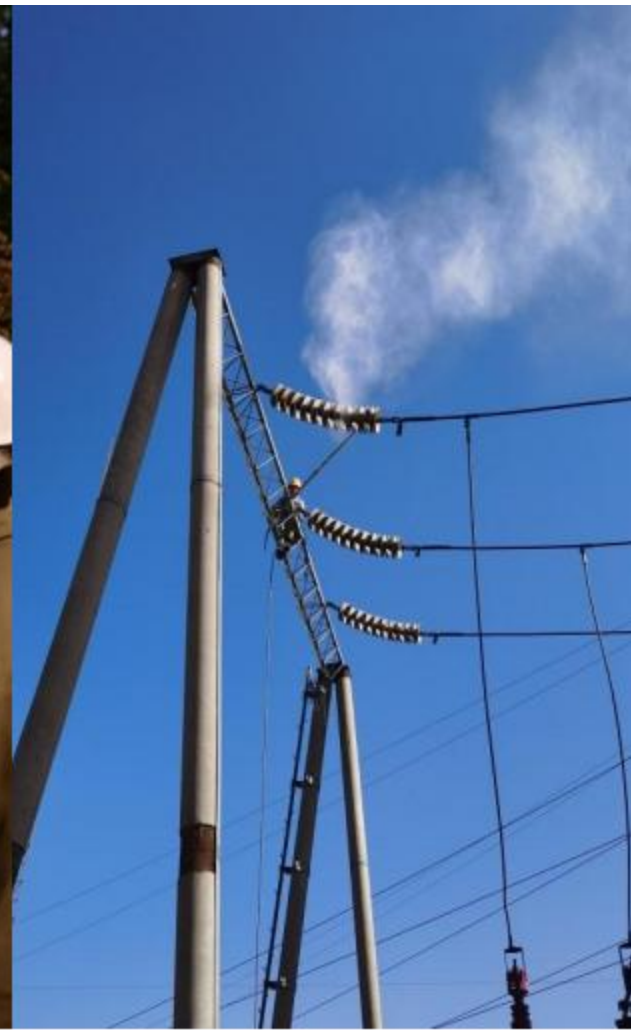
高空设备带电清洗
