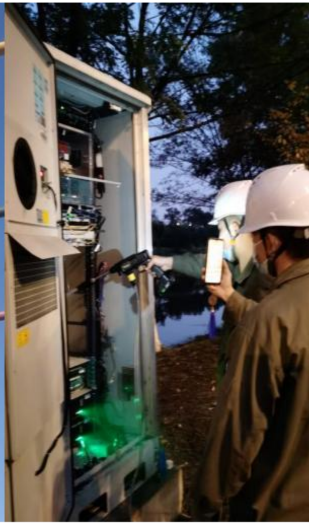
通信设备带电清洗
