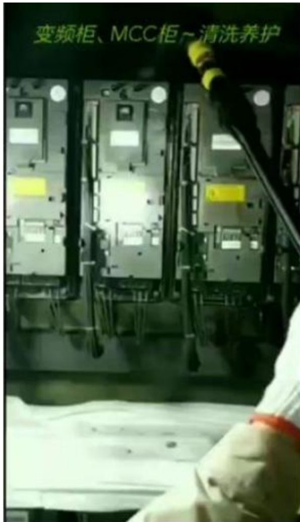
变频柜、MCC柜带电养护
